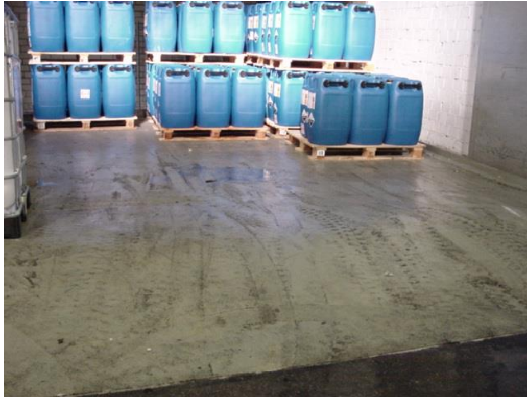
Befahrbare Auffangwanne mit Schwallkante
