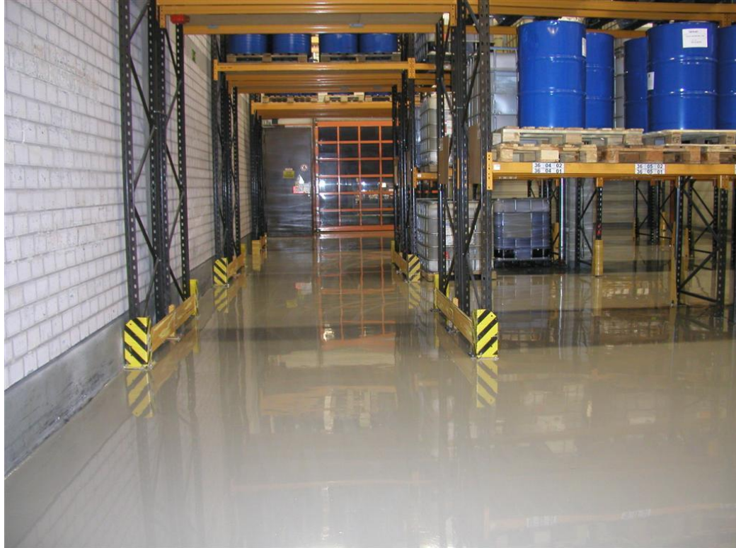
Lagerhallenboden mit Flurförderzeugen befahren
